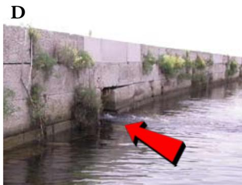
1a. Stazione 1: fossato dell'ex-forte prima (A) e dopo (B) i lavori di consolidamento e manutenzione della diga foranea e delle sponde dell'ex-forte [MAG. ACQUE, 1998]. Nelle figure (C) e (D), prima e dopo i lavori, particolare dell'area della piccola chiusa (indicata dalla freccia) che mette in comunicazione diretta il fossato con il portocanale esterno.
